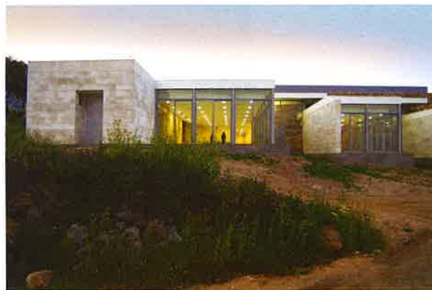
Gaia + Chermayeff, l'acquario Mario della Sardegna, Calagonone (NU), I lotto: 2004-2006; II lotto: 2009-2010
